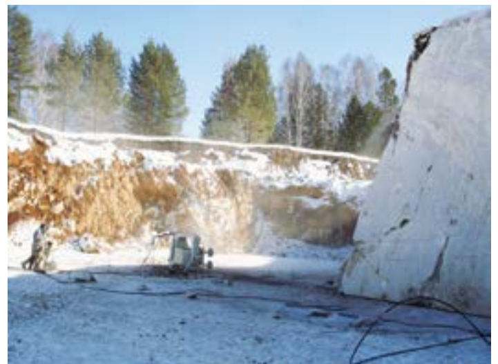
Рис. 2. Отделение монолита трещиноватых пород от массива в вертикальной плоскости алмазно-канатной машиной
