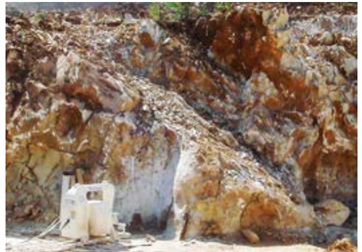
Рис. 1. Отделение монолита трещиноватых пород от массива в горизонтальной плоскости алмазно-канатной машиной
